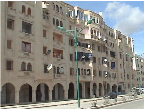
Figure n° 04 : Photo façade d'ensemble
