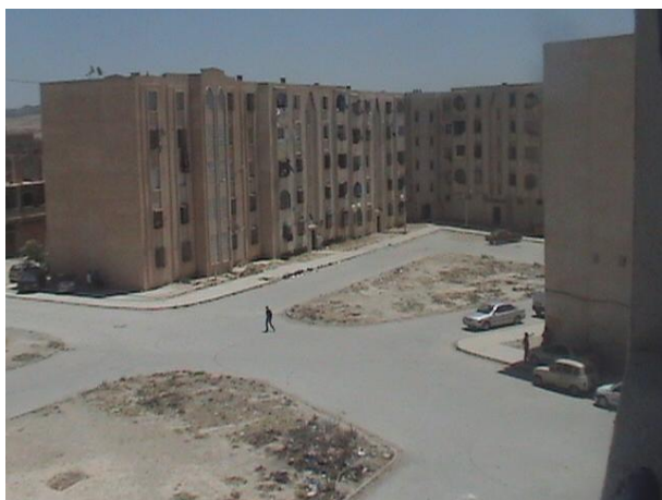
Figure n° 22 Photo sur espace interne
