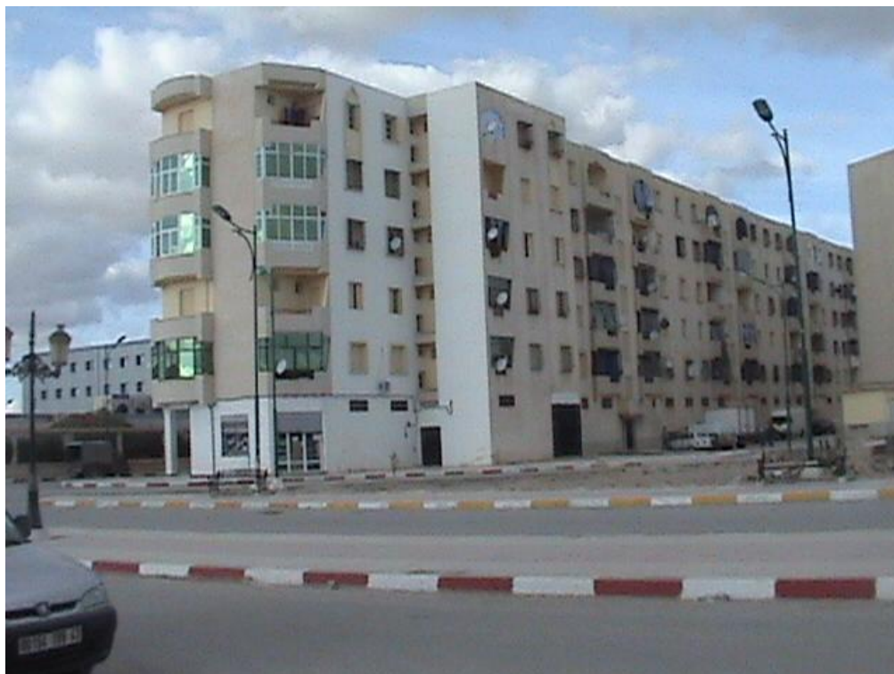
Figure N° 25 : photo sur bâtiment d'angle (fait par auteur)
