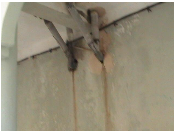
Figure N° 42 : Mauvaise conception et de réalisation des descentes source : auteur
