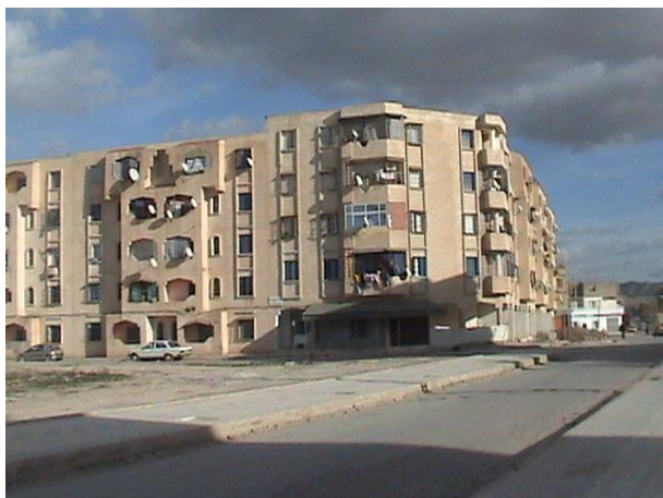
Figure n° 20 Photo façade d'ensemble
