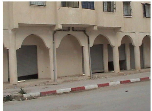
Figure N° 42 : Mauvaise conception et de réalisation des descentes source : auteur
