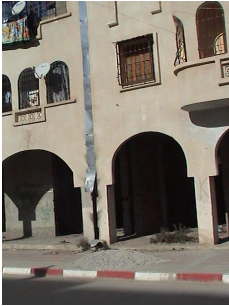
Figure N° 43 : Etat des couvres joint source : auteur
