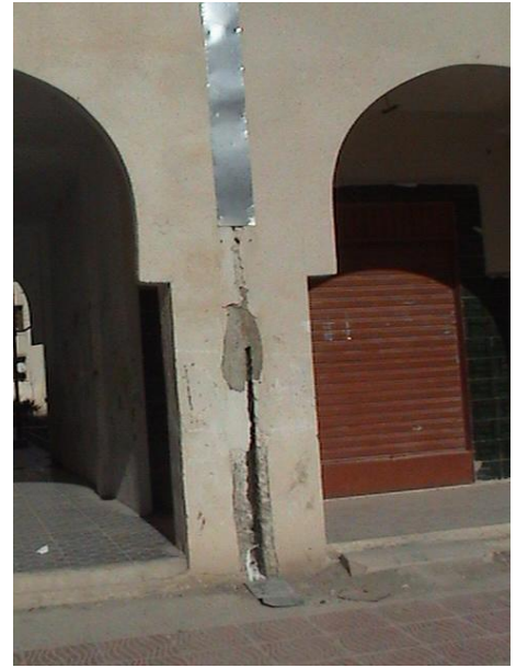
Figure N° 43 : Etat des couvres joint source : auteur
