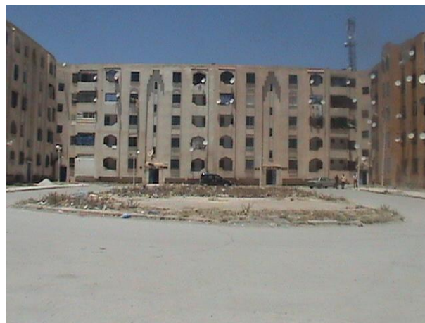
Figure n° 23 Photo sur espace interne
