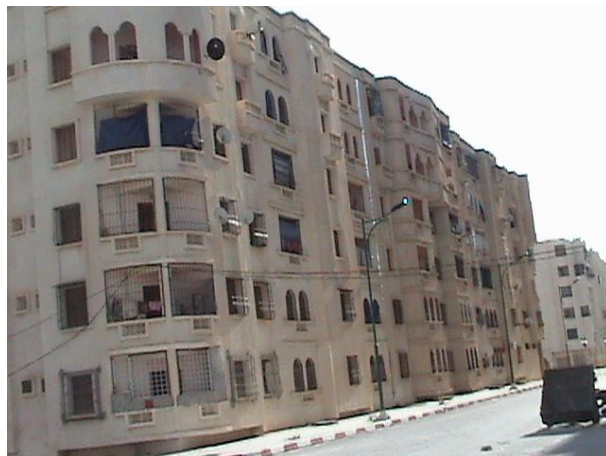
Figure 45 : Pose systématique du barreaudage source : auteur
