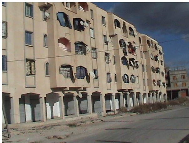
Figure n° 21 Photo façade d'ensemble
