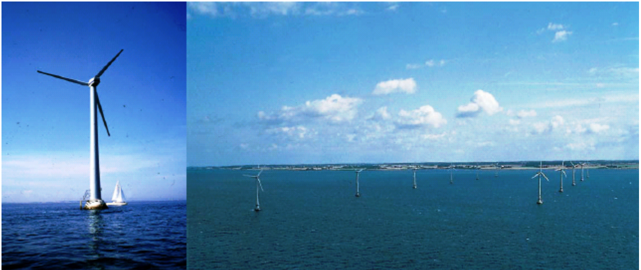
Figure I.1 : Première ferme éolienne offshore en Baltique Danemark (Vindeby)
