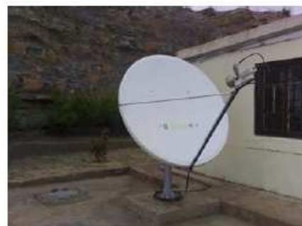
**Figure III.9 :** Transmission par satellite (VSAT) des données de la station vers le Datacenter (Alger).
